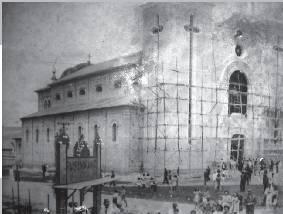
Igreja Matriz da Imaculada Conceição em construção
