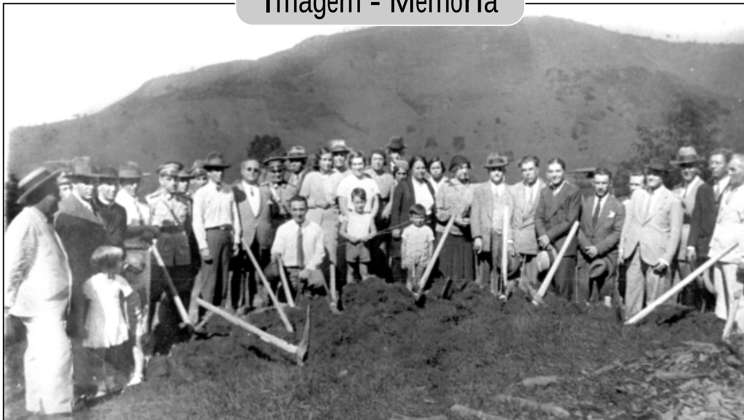
Autoridades de Piquete, Lorena e Itajubá, por ocasião do reinício das obras de adaptação e ampliação da estrada Lorena-Itajubá, no trecho de serra, na Tabuleta, em Piquete. Agachado, o prefeito de Piquete, Lydio de Souza Santos. Foto de 20 de outubro de 1934.
