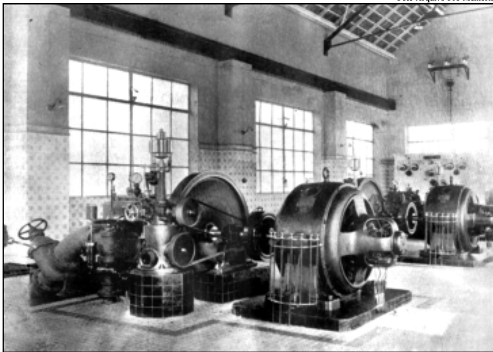
Grupo de geradores no interior da usina hidrelétrica Rodrigues Alves quando de sua inauguração, em 15.09.1906.
