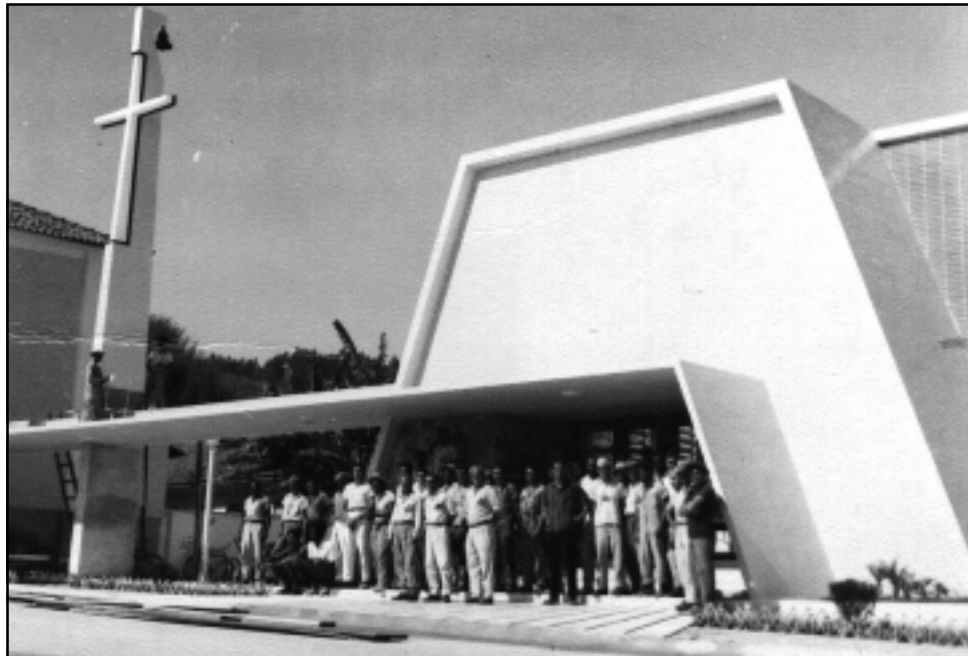
Operários trabalhando na construção da Capela do Hospital: década de 60
