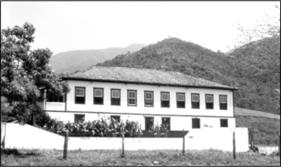
Vista lateral da Fazenda Santa Lydia, em Piquete. Foto de outubro de 2000.
