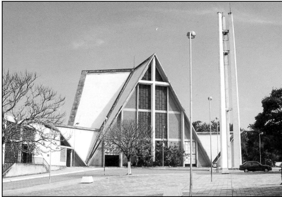
Igreja Matriz de São Miguel Arcanjo. Obra do arquiteto Prometheu da Silveira, inaugurada em 27 de janeiro de 1970.
