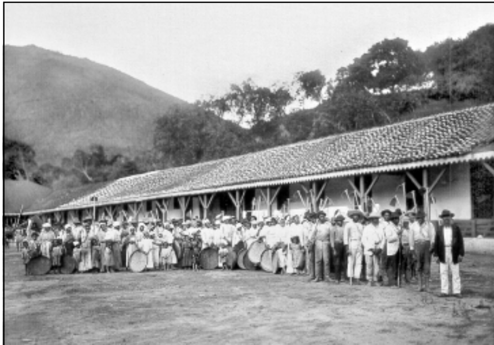
“Partida para o Cafezal”, fotografia de Marc Ferrez: 1881 - 1886. A mão-de-obra escrava foi utilizada no Vale do Paraíba em função da cultura cafeeira, no século XIX. Após a Lei Áurea a escravidão tornou-se ilegal.
